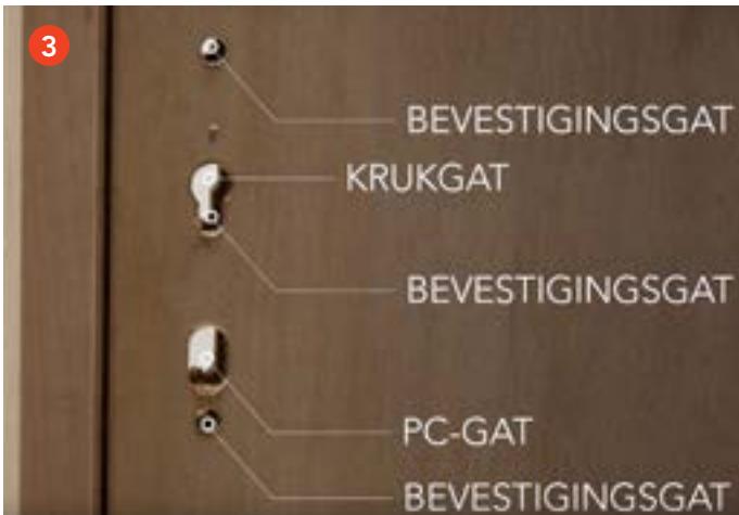
3 Demonteer deurbeslagmal Controleer alle gaten
