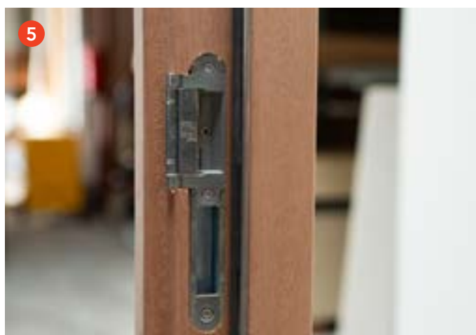
5 Demonteer sluitkommen freesmal Demonteer de sluitkommen mal en monteer de sluitkommen.
