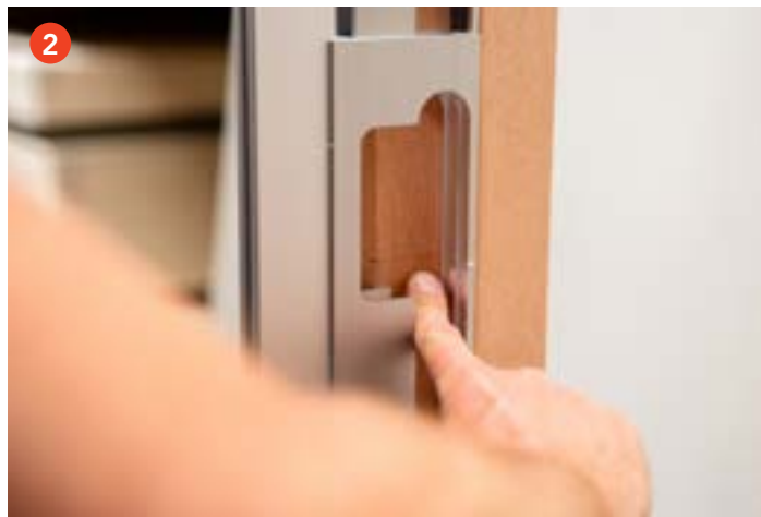
2 Monteren sluitkom freesmal Houd de markering op de mal gelijk aan de afgetekende markering op het kozijn (zie hoofdstuk monteren aanslagmal) en schroef de mal in het kozijn.
